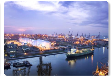
탄중 프리옥 탱크 터미널 (인도네시아)
